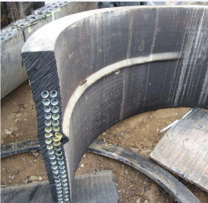
**Abbildung 26: Schacht X mit Einbeulung**
