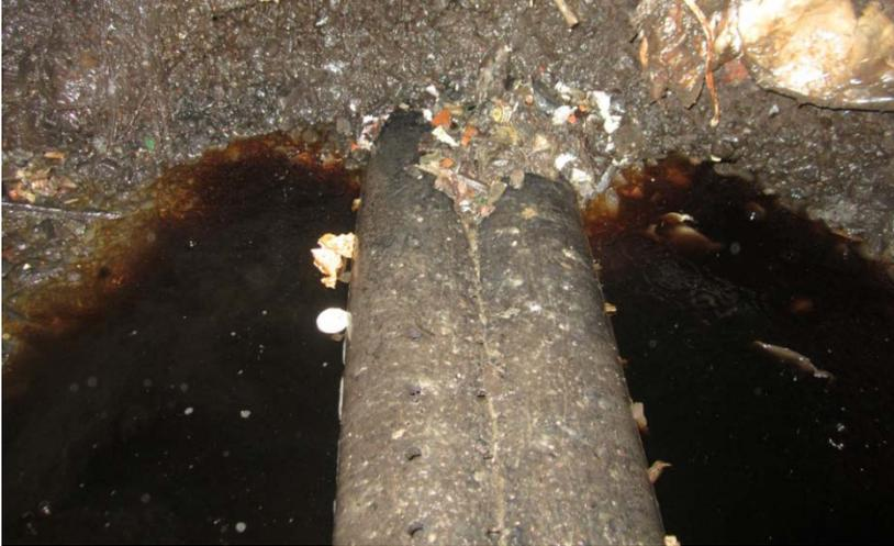
**Abbildung 25: Kollabiertes Rohr in der Deponie Y**
