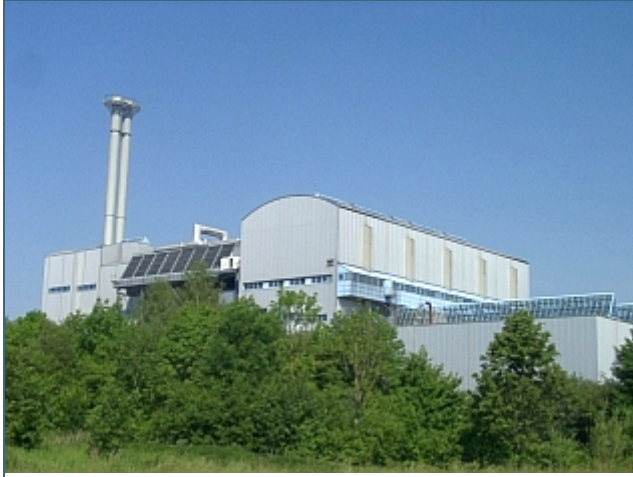
Das Müllheizkraftwerk (MHKW) Weißenhorn
