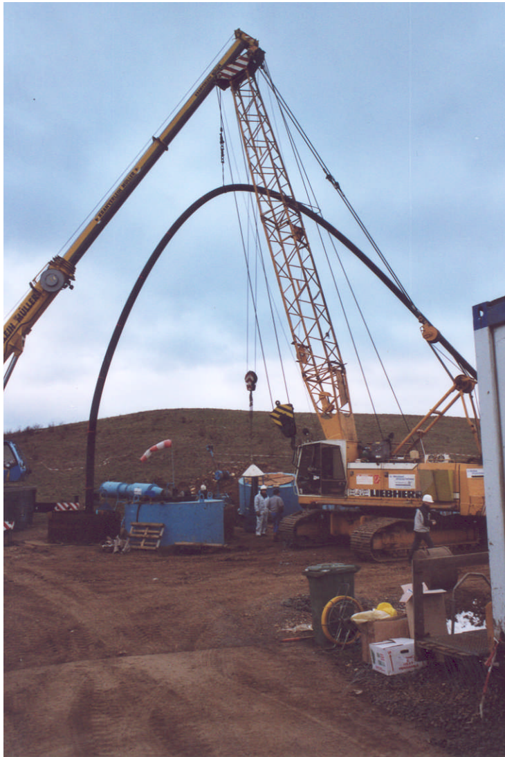
Bild 15 Ausführung Biegeradius
