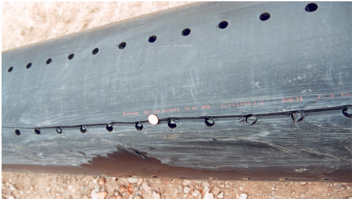
Bild 5 Deponie Medbach - Riefe vor dem Einziehen
