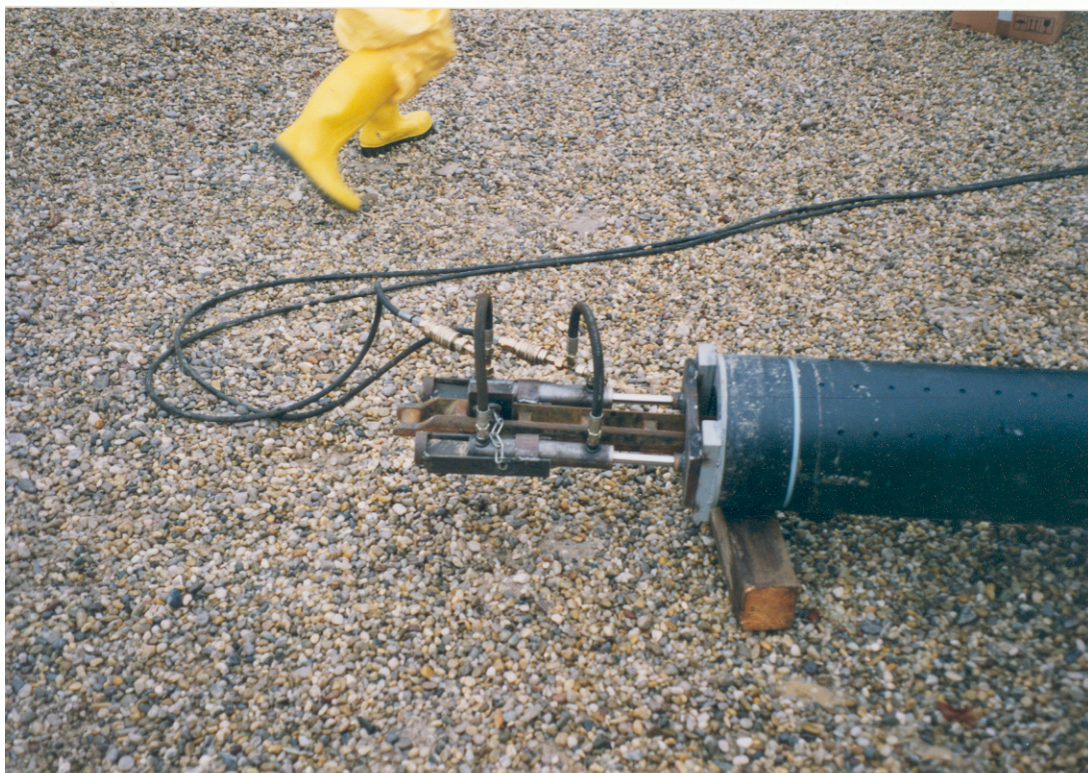
Bild 16 a / b Enddeckel einer zugfesten Verbindung eines Rohrstranges beim Kurzrohrberstlining
