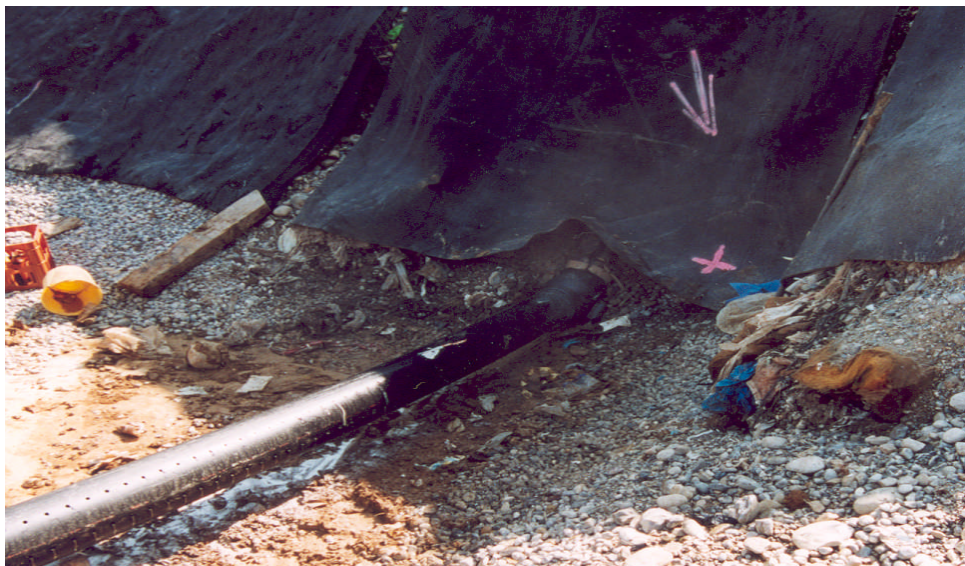
Bild 14 Ebenerdiger Ansatz einer Berstrakete Dynamisches Langrohr Berstlining auf der Deponie Oberostendorf
