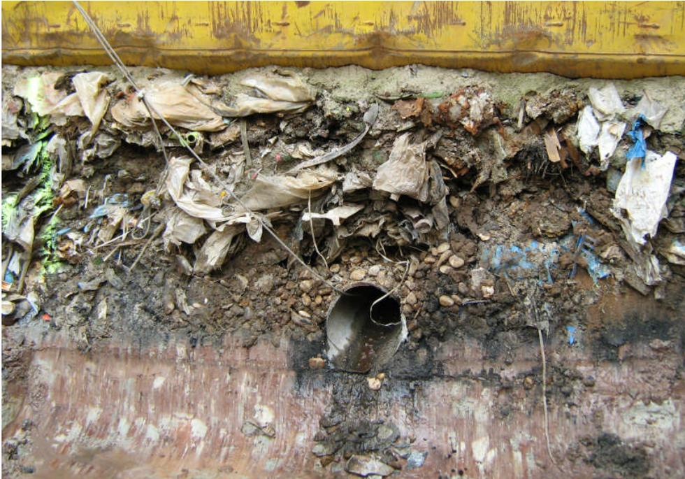
**Abbildung 3-2:** Freigelegte Basisabdichtung in der Baugrube SS1, Deponie „Im Dienstfeld“
