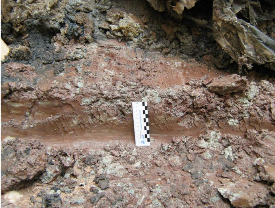
**Abbildung 3-3:** Detailaufnahme des oberen Abschnitts der Basisabdichtung in der Baugrube SS1, Deponie „Im Dienstfeld“
