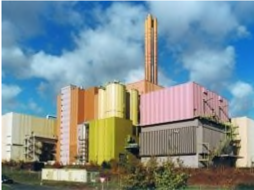
Das Müllheizkraftwerk (MHKW) Würzburg
