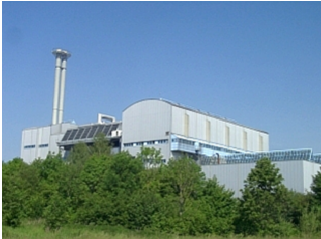
Das Müllheizkraftwerk (MHKW) Weißenhorn
