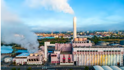
Das Müllheizkraftwerk (MHKW) Schweinfurt
