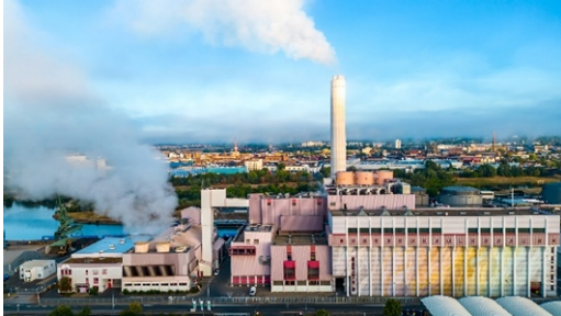
Das Müllheizkraftwerk (MHKW) Schweinfurt
