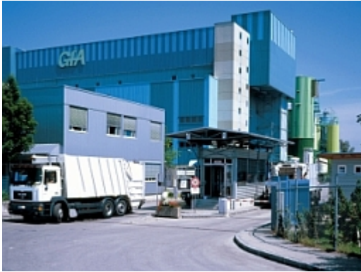
Das Abfallheizkraftwerk (AHKW) Geiselbullach
