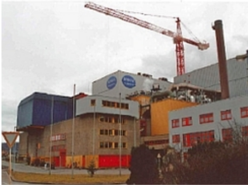
Das Müllheizkraftwerk (MHKW) Bamberg
