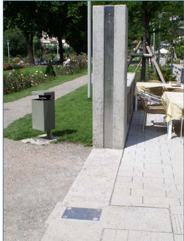
Abb. 19: Durchgang in Bad Kissingen – Split setzt sich schnell in den Schraubköpfen fest; Abdeckkappen helfen nur bedingt (leicht entfernbare)
