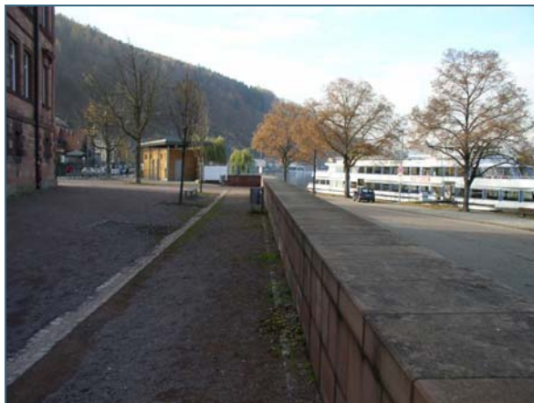
Abb. 3: Entlastungsstrecke in Miltenberg – die stationäre Mauer ist auf ein HQ 100 ohne Freibord bemessen
