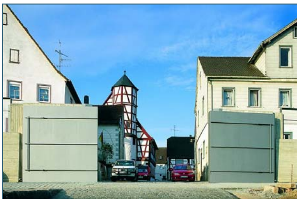
Abb. 1: Standardsystem des mobilen Hochwasserschutzes - offenes Stemmtor in Wörth am Main
