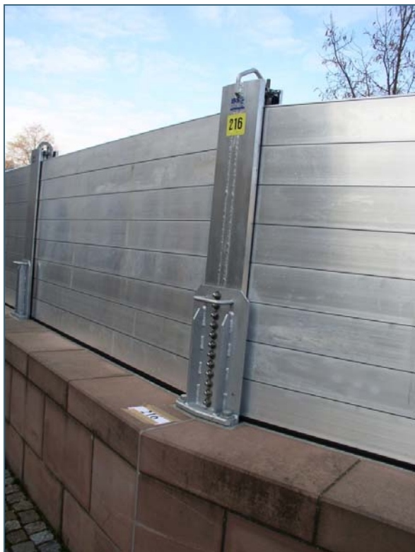
Abb. 4: Markierung von Sonderbauteilen in Miltenberg an der Stütze und am Einsatzort (noch provisorisch gekennzeichnet)
