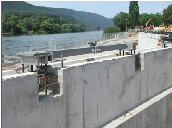
Abb. 7: Einbau von Ankerplatten in Miltenberg – durch das Aufschauben einer Schablone kann der exakte Achsabstand von 2,50 m eingehalten werden
