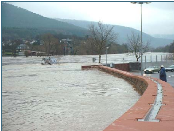
Abb. 9: Hochwasser in Miltenberg 2003 während der Bauphase – der feste Grundschatz (HQ 25 + Freibord) verhindert bereits größere Überschwemmungen; im Hintergrund sind mobile Elemente für den Lückenschluss erkennbar
