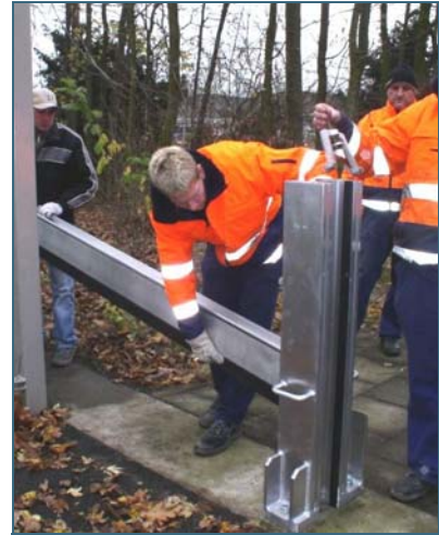
Abb. 16: Probeaufbau eines Durchgangs in Köln – Einsetzen der ersten Dammbalkenlage mit Fußdichtung
