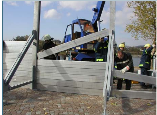
Abb. 8: Probeaufbau in Miltenberg – die ersten 8 Dammbalkenlagen können ohne Hilfsmittel gesetzt werden; für das sorgfältige Einsetzen sind mindestens 2 Personen nötig
