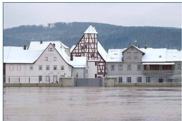
Abb. 2: Das gleiche Tor geschlossen und eingestaut beim Hochwasser im Januar 2003
