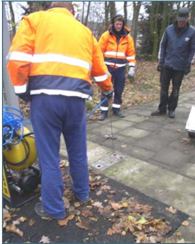
Abb. 14: Probeaufbau eines Durchgangs in Köln – die Schraublöcher der Ankerplatte werden mit Druckluft gereinigt
