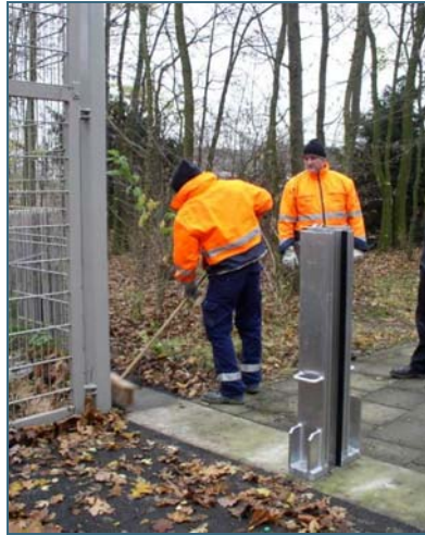
Abb. 15: Probeaufbau eines Durchgangs in Köln – nach dem manuellen Setzen der Stütze wird die Aufstandsfläche gesäubert
