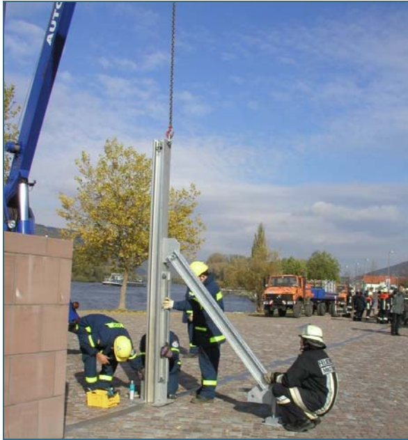
Abb. 6: Probeaufbau von Stützen in Miltenberg – aufgrund des großen Eigengewichtes der 3,20 m hohen Stahlstütze kann diese nur mit Hilfe eines Kranes gestellt werden
