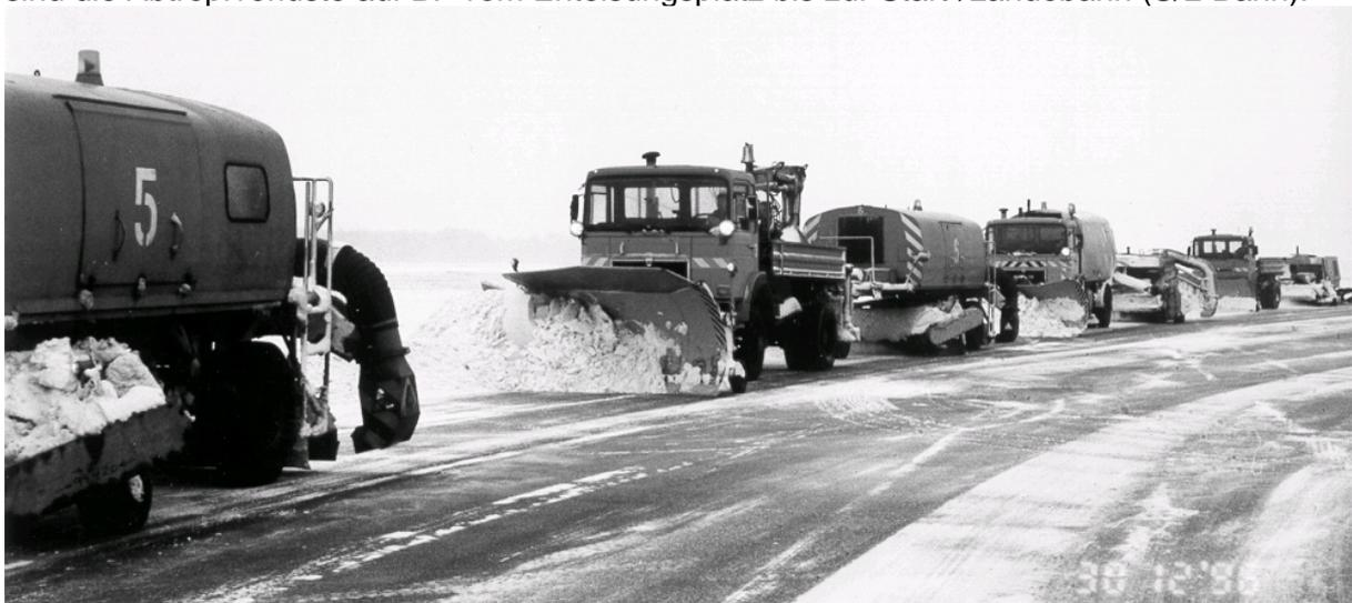
Abb.3: Mechanische Räumung
