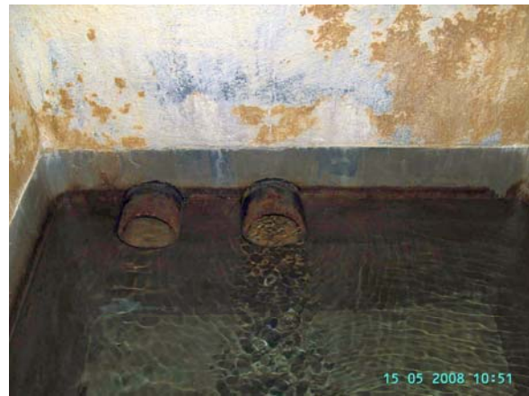
Abb. 40: Quellzuläufe teilweise unter der Wasseroberfläche (Foto: LfU)
