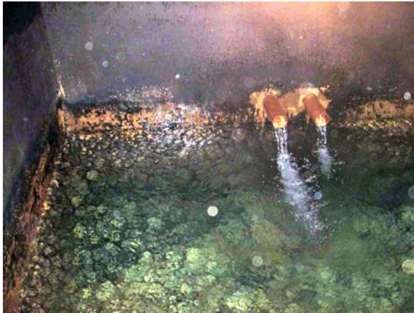
Abb. 39: Quellzuläufe über der Wasseroberfläche (Foto: LfU)
