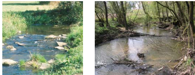
Einbau von Störsteinen
