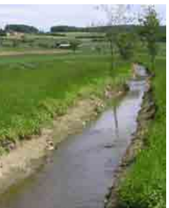
▲ Abfluss nicht durch überdimensionierte Gewässerräumung beschleunigen.
