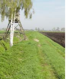
▲ Beidseitige Uferstreifen ggf. mit Fahrweg erleichtern die Unterhaltung (Zugänglichkeit). Auch werden dadurch unerwünschte Einträge aus angrenzenden Nutzflächen zurückgehalten.
