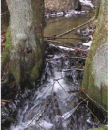
▲ Verklausung durch Geschwemmel: Für Gewässerorganismen i.d.R. kein Problem.
