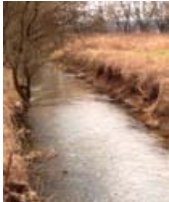
▲ Gewässer, begradigt und eingetieft: Hochwasser fließt ungebremst ab.
