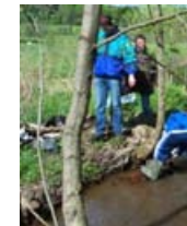
▲ Bachpaten beseitigen ein Abflusshindernis aus Plastikplanen.
