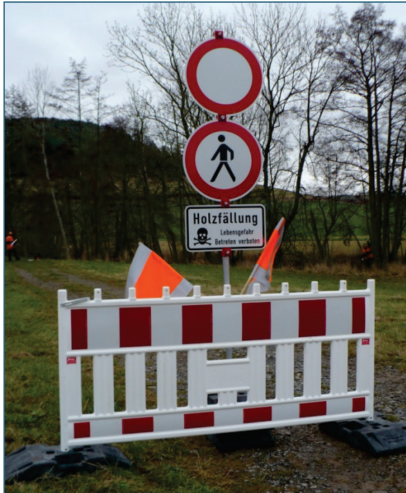
Abb. 1: Beispiel für eine Absperrung und Erläuterung der Bestandteile, die eine Absperrung in der Regel umfasst: - Zeichen 250, 600 - Schild mit Totenkopf - 2 Fahnen am Ständer - Absperrung mit der Barke im Nahbereich - Hier wurde in Absprache mit dem Landratsamt zusätzlich das Zeichen 259 (Verbot für Fußgänger) aufgenommen.
