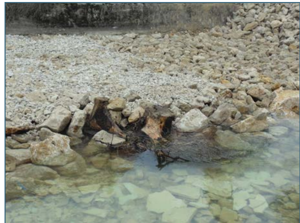
Abb. 41: Einbau von Totholz, Juraschotter und Plattenkalkmaterial zur Strukturverbesserung
