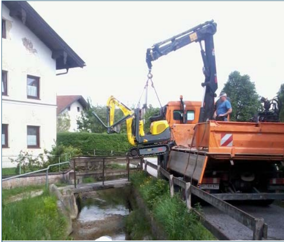
Abb. 23: Arbeiten im Gewässerbett mit dem Minibagger
