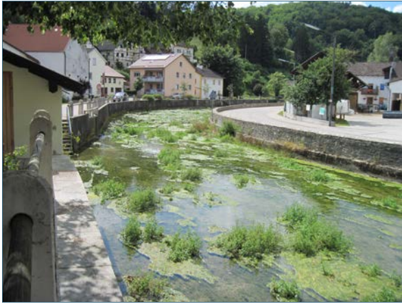
Abb. 38: Gailach in Mühlheim vor dem Ausbau: üppiger Wasserpflanzenaufwuchs in den Sommermonaten
