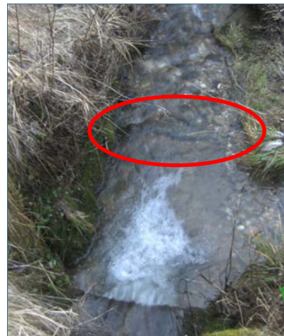
Abb. 13: Frei liegende Wasserleitung auf der Gewässersohle.
