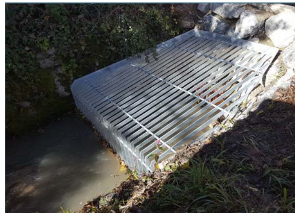
Abb. 8: Ein räumlicher Rechen vor einer Verrohrung als Schutz vor Verklausungen.
