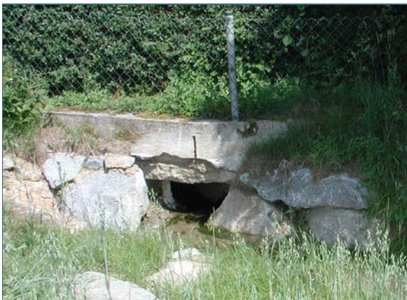
Abb. 7: Eine durch den Anlieger errichtete Verrohrung verschärft die Hochwassergefahr für die Oberlieger.
