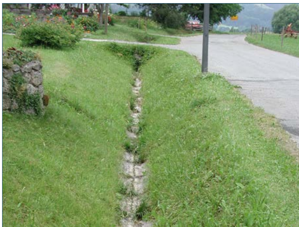
Abb. 14: Befestigte Sohle und zu kleine Durchlässe für einen Bach mit ausgeprägten Hochwässern
