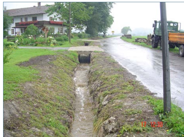
Abb. 15: Gestaltung einer natürlichen Kiessohle und Vergrößerung der Durchlässe
