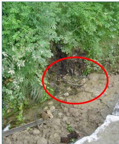
Abb. 12: Nach einem Uferabbruch liegt das Telefonkabel frei.
