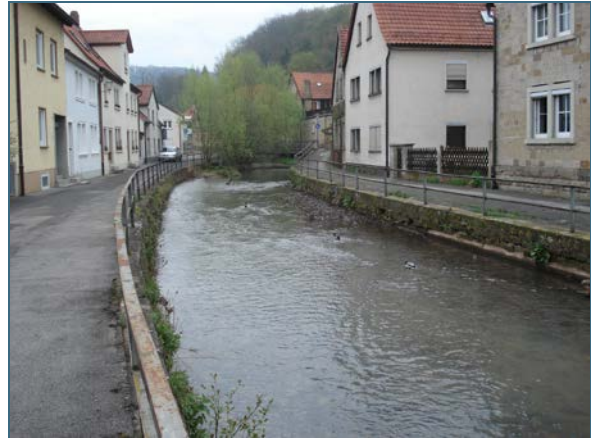
Abb. 27: Alter Bachabschnitt, auffällige Ufermauern, naturfernes Gewässerprofil, 1991
