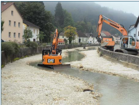
Abb. 40: Abschlussarbeiten in der renaturierten Gailachkүнette
