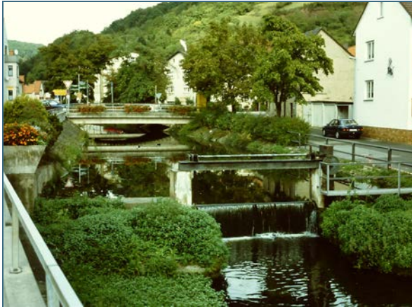
Abb. 26: Altach aufgestaut, ca. 1985, vor der Baumaßnahme
