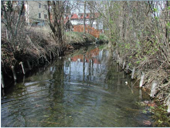
Abb. 34: Hachinger Bach BA II: Monotoner Bachlauf mit steiler Böschung und Resten der Ufersicherung
