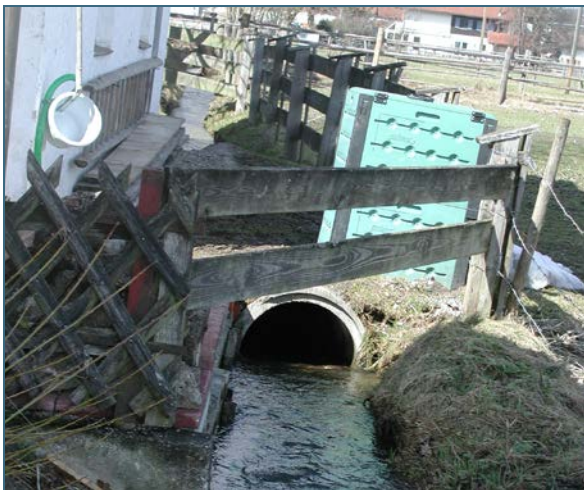
Abb. 9: Ein verrohrter Gewässerabschnitt...
