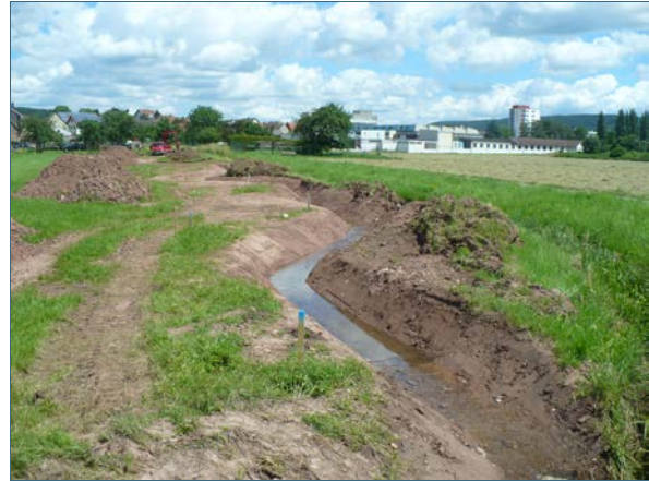
Abb. 31: Deißelbach während der Bauarbeiten
