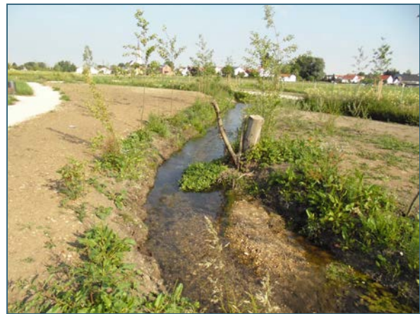
Abb. 45: Einbau von Kiesbänken, Totholz und Initialpflanzungen
