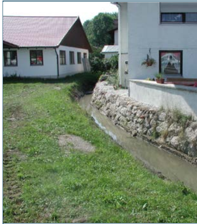
Abb. 17: Trockenmauer direkt nach dem Bau
