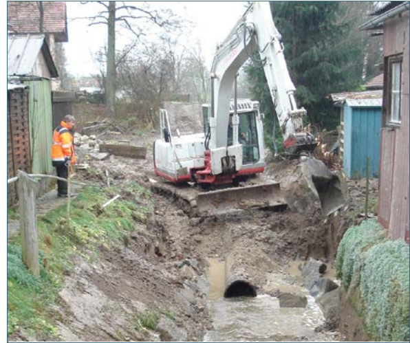
Abb. 24: Temporäre Verrohrung für Arbeiten mit schwerem Gerät
