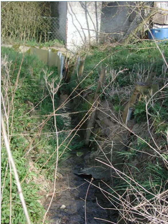
Abb. 19: Unsachgemäßer Uferverbau durch Anlieger
