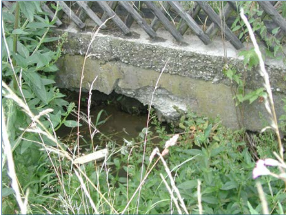
Abb. 21: Unterspülte Ufermauer
