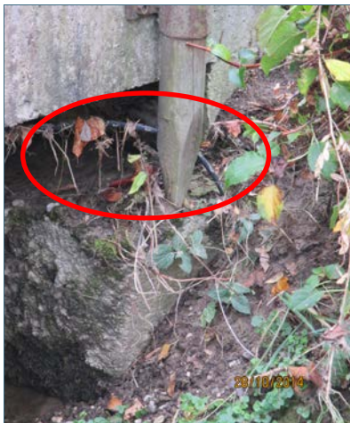
Abb. 11: Abgerissenes Telefonkabel nach der Böschungsmahd im Brückenbereich.
