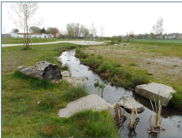
Abb. 44: Gewässerübergänge aus Kalksteinquadern
