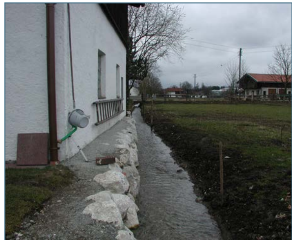
Abb. 10: wird wieder geöffnet. Zur Sicherung der Hausmauer ist eine Trockenmauer errichtet worden.
