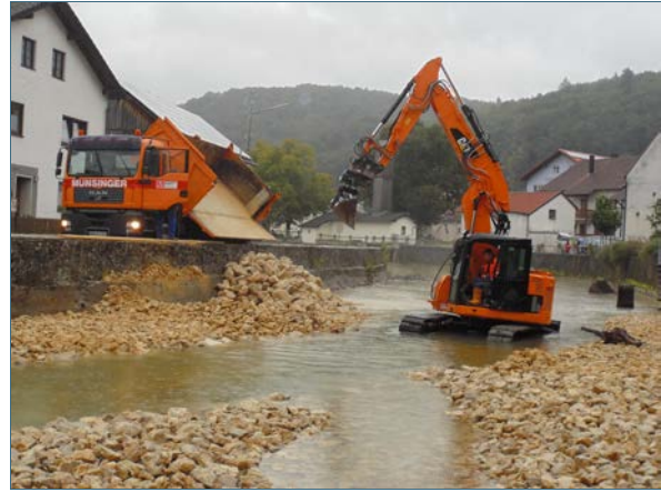
Abb. 39: Einbau des Deckwerks aus Kalkschotter im Uferbereich
