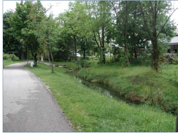
Abb. 35: Hachinger Bach BA II: Verlegter Bachlauf mit Zugang zum Gewässer entlang des Fußweges
