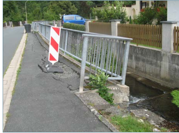
Abb. 22: Schadhafte Ufermauer
