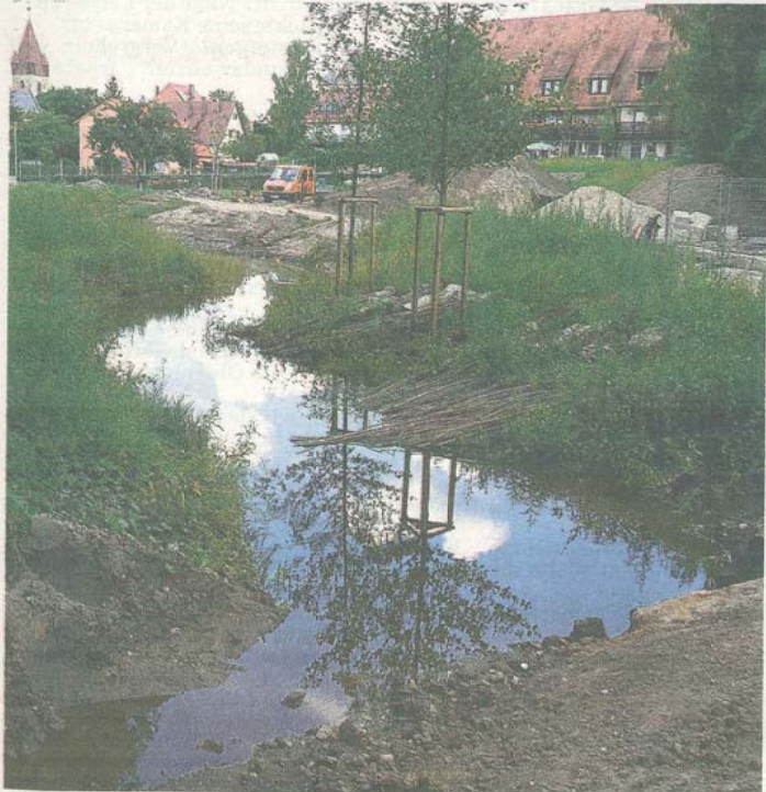
Das Bett des Gauchsbaches wurde von den Privatgrundstücken wegverlegt. Er schlängelt sich nun durch das Tal.
