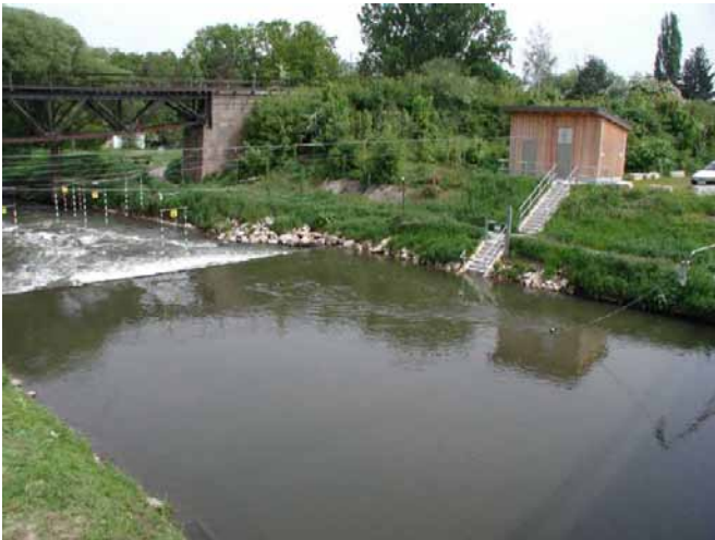
Pegel Neumühle/Rednitz WWA Nürnberg Neubau der Seilkrananlage
