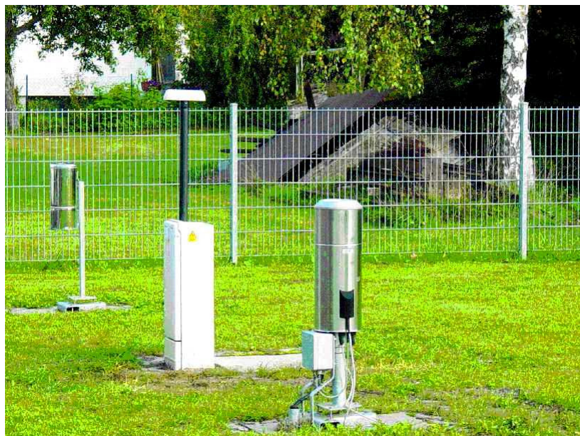
Ombrometerstation mit folgenden Komponenten (v. lks. nach re.): Niederschlagsmesser nach Hellmann, Stationsrechner mit ISDN-Anschluss und Pluviometer der Fa. Ott
