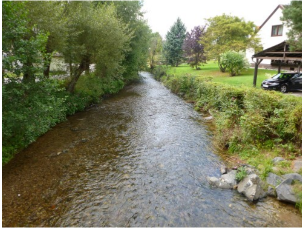
Abb. 1: Ist-Situation 2012 im Ortsbereich Musterkirchen: : begradigter Bachlauf ohne Struktur und mit eingetiefter Sohle (Foto: XY)
