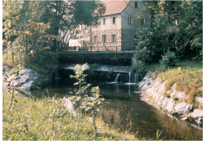
Abb. 2: Ist-Situation 2013 bei Beispieldorf: Wehr mit Ufersicherung (Foto: XY)
