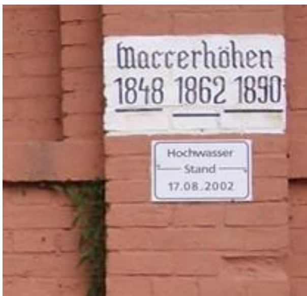
Abb. 1: Hochwassermarke an der Elbe unterhalb von Dresden
