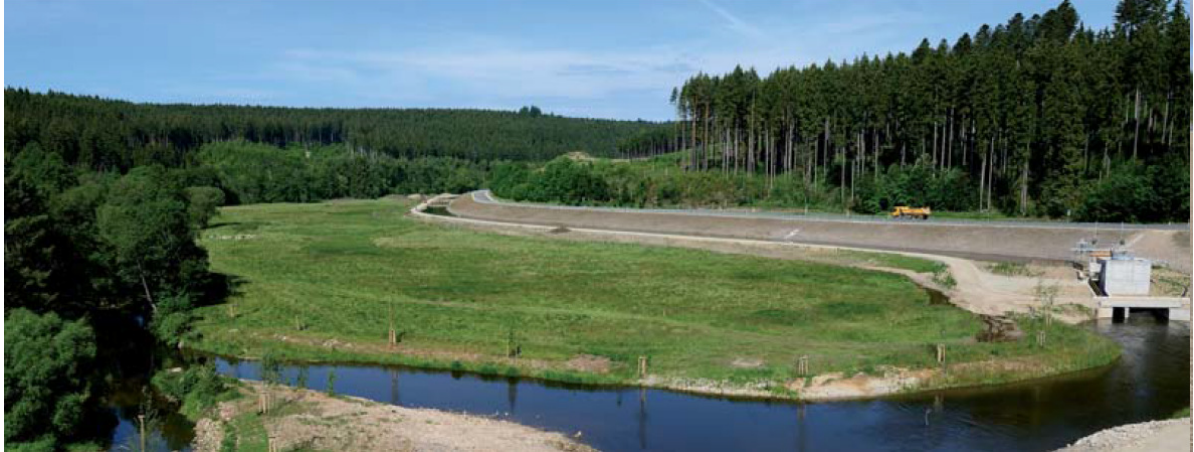
Abbildung 9: Hochwasserrückhaltebecken an der Breg [Quelle: Regierungspräsidium Freiburg]
