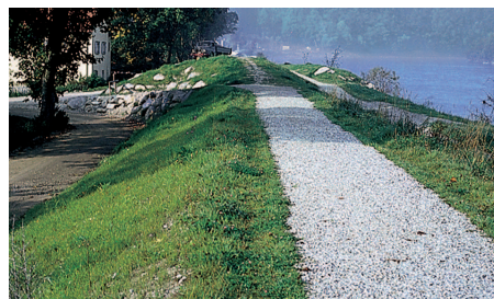
Technischer Hochwasserschutz: Deiche und Schutzmauern
