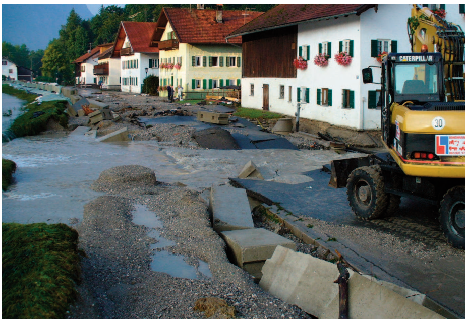
Das Hochwasser in Eschenlohe im August 2005 richtete enorme Schäden an.
