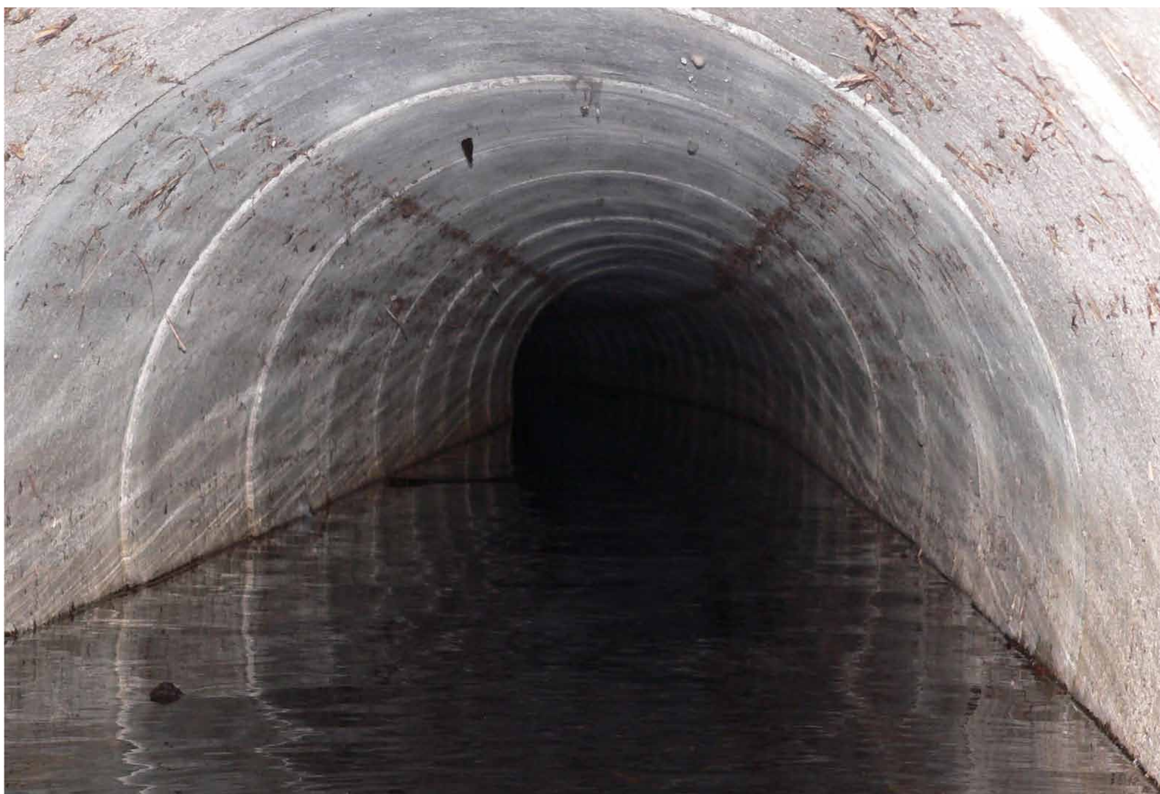
Ein intakter Kanal – alles dicht
