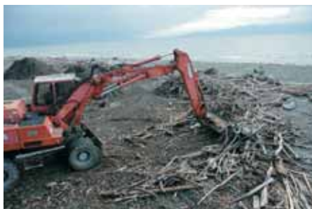
Mit einem Radbagger wurde ein durch Treibholz stark geschädigter Strandabschnitt wiederhergestellt.
