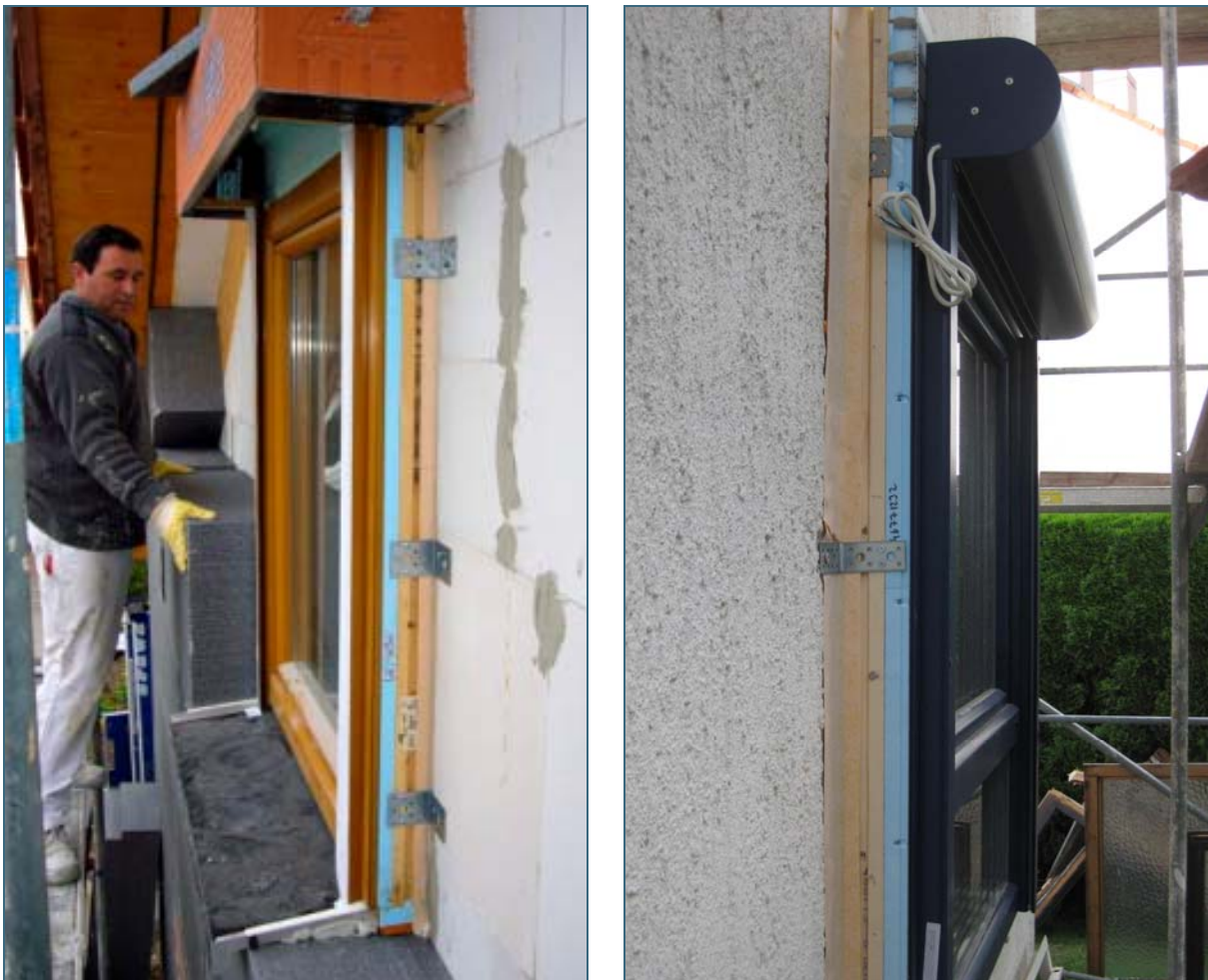
Abb. 5 und 6: Bewährte Lösungen für Rollokästen im Neubau- (links) und Sanierungsfall (rechts)
