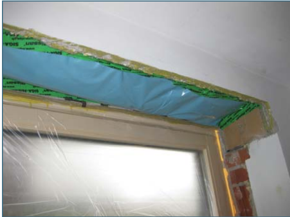
Abb. 20: Die beste Lösung ist es oft, alte Rollokästen stillzulegen und an die neuen Fenster außenliegende Rollokästen anzubringen.
