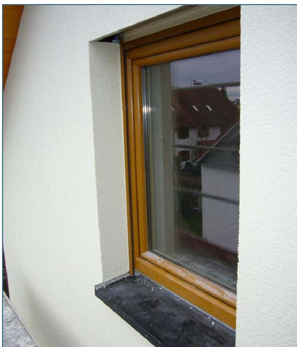
Abb. 4: Dank der – bereits bei der Planung berücksichtigten – nach außen in die Dämmschicht verlegten Position der Fenster ergeben sich auch bei fast 30 cm Dämmstärke keine „Schießscharten“
