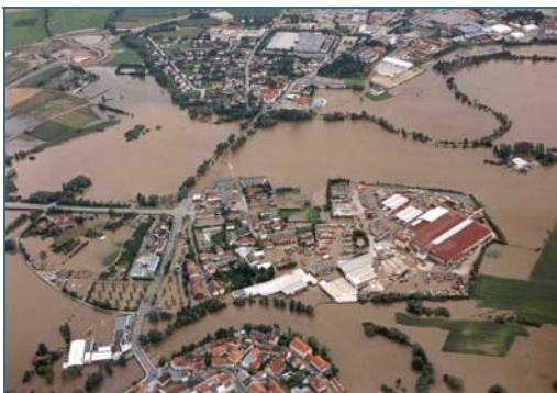
Abb. 1: Unverträgliche Auennutzung: Überschwemmtes Gewerbegebiet
