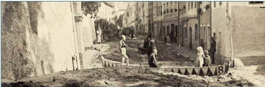
Naturereignis Hochwasser – Schlammablagerungen nach Hochwasser in Burghausen 1899
