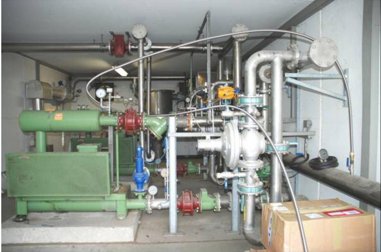
Abb. 5 Deponiegas-Aufbereitung (Kondensatabscheidung/Trocknung, Verdichtung) an der Deponie B (rechts vorne: Probenahmestelle PCDD/PCDF-Beprobung des Deponiegases)
