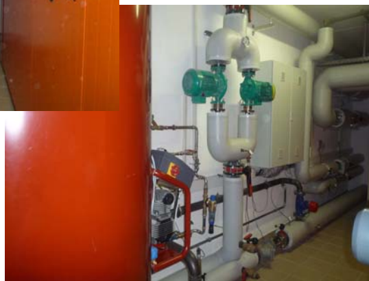
Redundante Hauptspeisepumpen
