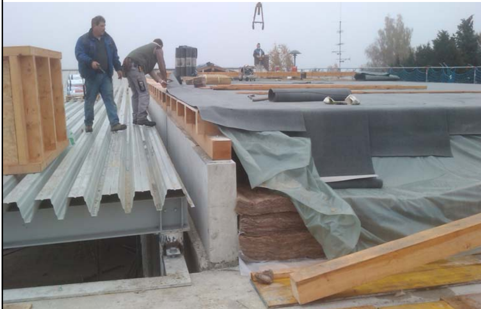
Dämmmaterial 50 cm auf dem Dach
