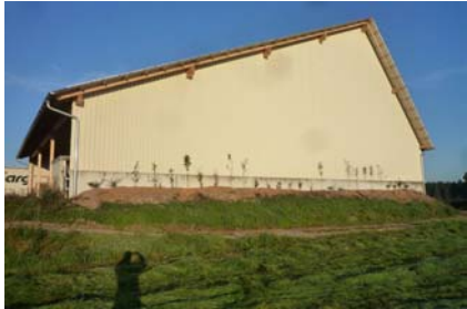
Durch Überdachung umfunktionierte Fahrsilos zum Hackschnitzellager mit PV Anlage.
