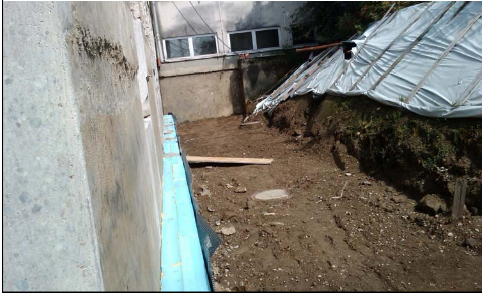
Dämmmaterial 1,5 m im Boden 30 cm stark
