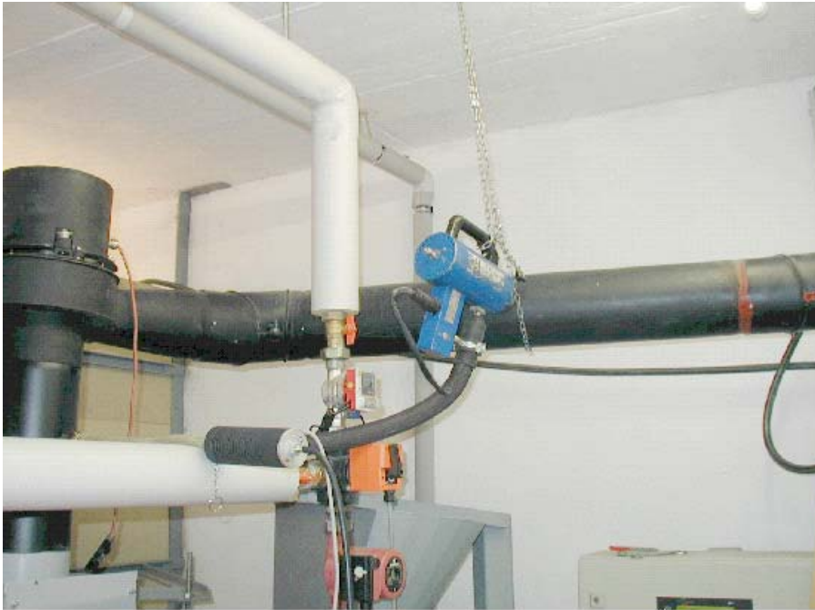
Abb. 3: Probenahmestelle Anlage C 3
