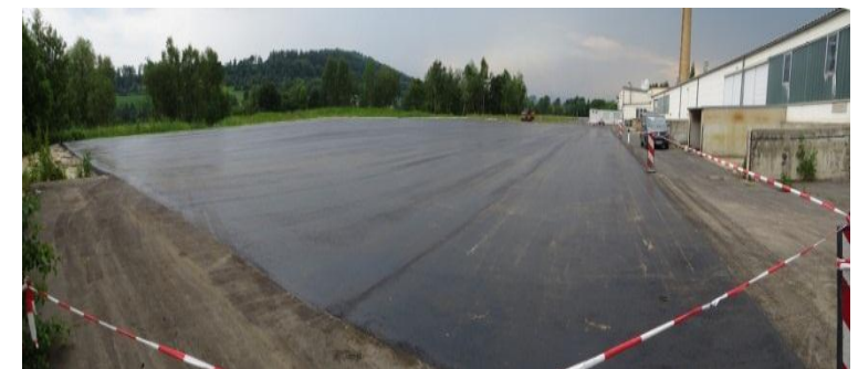
Abgeschlossene Oberflächenversiegelung
