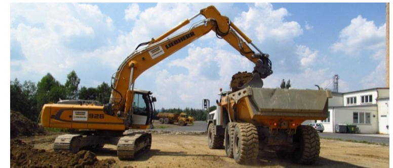
Profilierung der Oberflächenversiegelung
