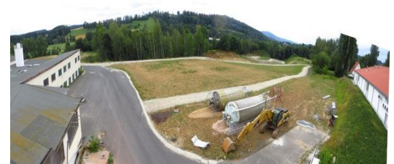
Übersichtsaufnahme südwestliches Fabrikgelände
