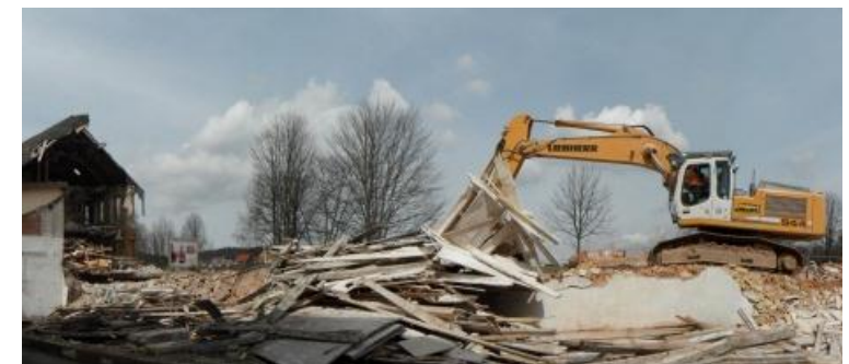
Abbruch des Mineralwerkes
