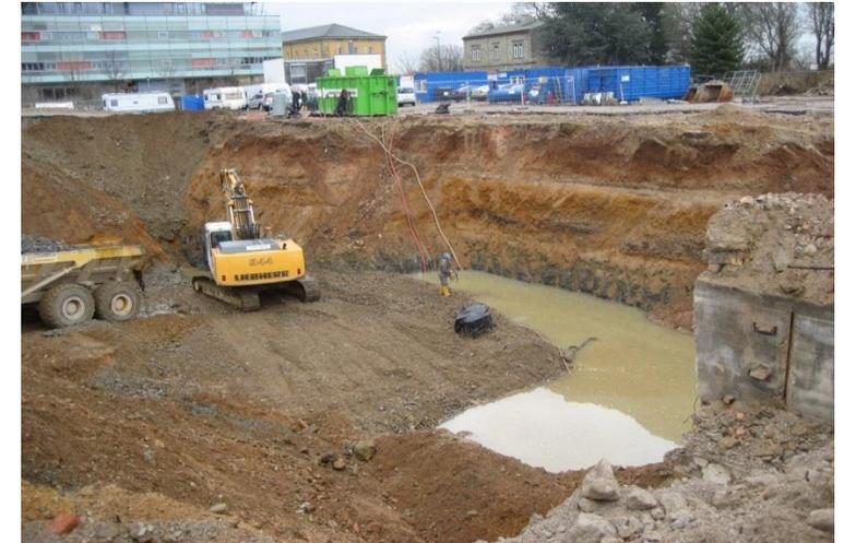
*Aushub von MKW-haltigen Bodenmaterial und Bauwasserhaltung*
