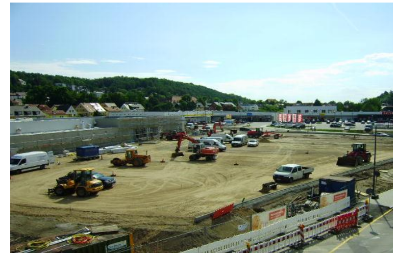
Baustelle des zweiten Bauabschnittes im Jahr 2014
