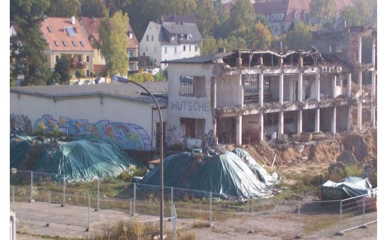
Abbrucharbeiten im Jahr 2009
