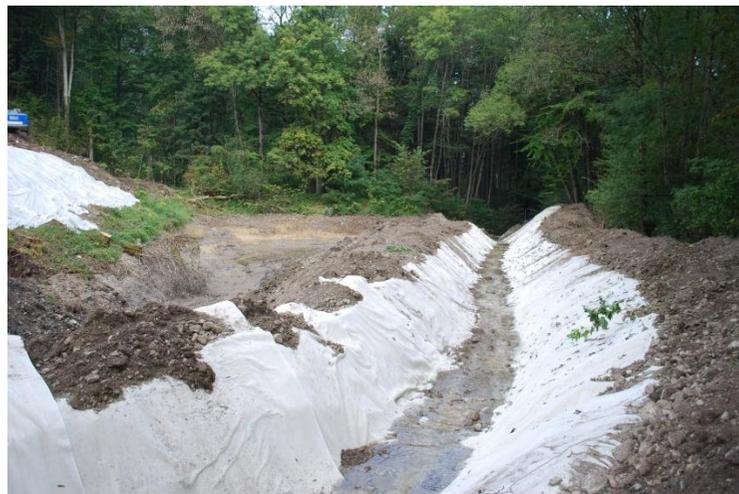
Provisorische Fassung des Tennbodenbachs während der Sanierung
