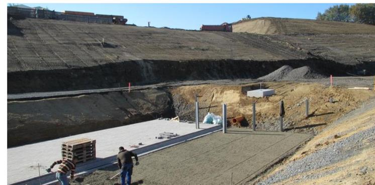
Profilierte Deponie und Bau des Regenrückhaltebeckens
