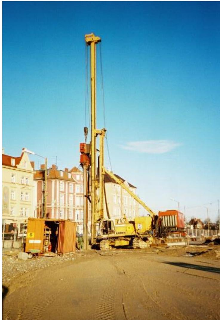
*Erstellung einer Spundwand zur Sicherung der Baugrube*
