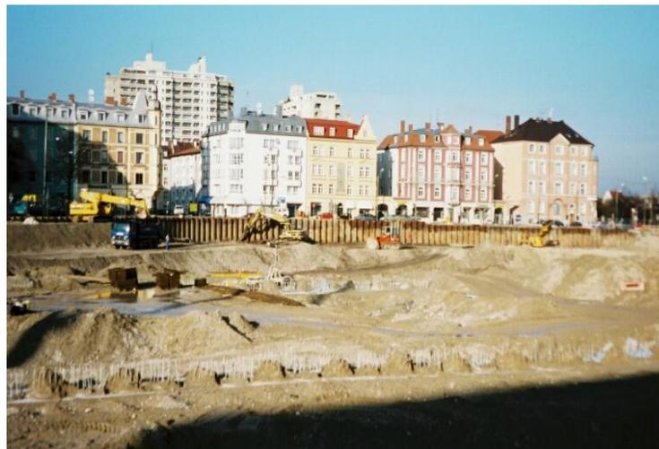
Sicherung der Baugrube, Aushub, Zwischenlagerung und fachgerechte Entsorgung des kontaminierten Auffüllungs- und Bodenmaterials
