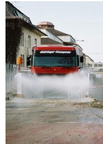
Arbeitsschutzmaßnahmen: eine Reifenwaschanlage für alle Fahrzeuge, die das Baustellengelände verlassen
