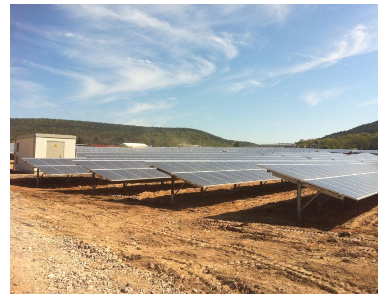
Neu errichtete Photovoltaikanlage
