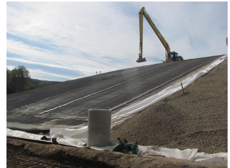
Verlegung der Dichtungsbahnen
