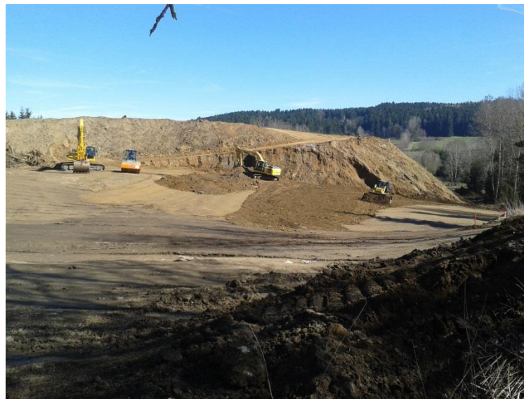
Umlagerungs- und Profilierungsarbeiten
