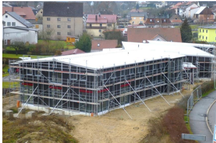
Bau des neuen Feuerwehrhauses
