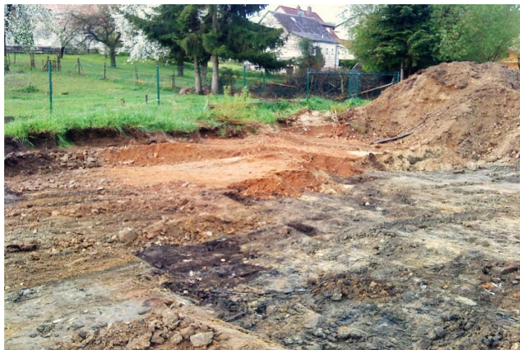
Aushubarbeiten (Auffüllung mit Ölverunreinigungen)
