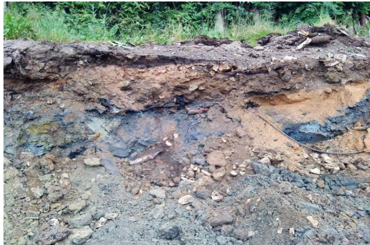
Anthropogene Auffüllungen mit Ölverunreinigungen
