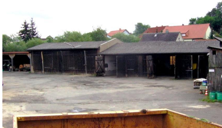
Ehemaliger Bauhof vor dem Rückbau
