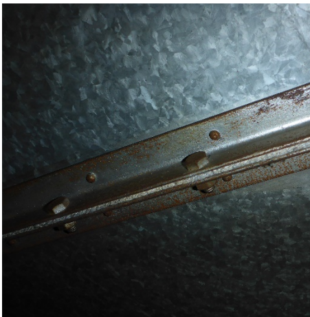
Abb. 1: Asbestschnur als Flanschdichtung
