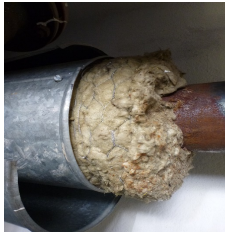
Abb. 2: Stopfmasse aus künstlichen Mineralfasern (KMF) als Rohrisolierung
