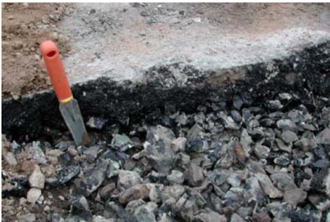
Abb. 1: Schwarzdecke auf Unterbau
