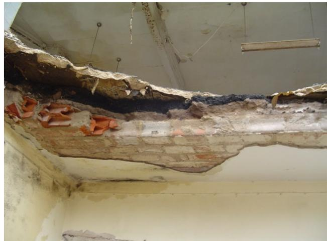
Abb. 2: Schlackeschüttung unter Estrich
