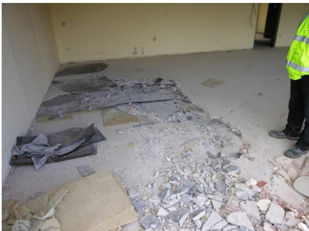
Abb. 1: Boden aus Zementestrich
