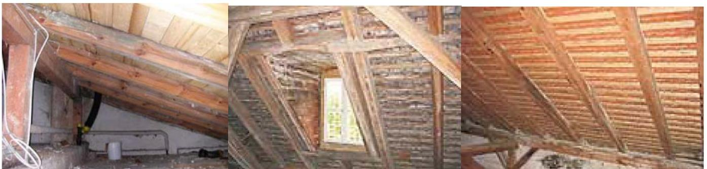
Abb. 1: Dachstuhlholz mit Verdacht auf Holzschutzmittel
