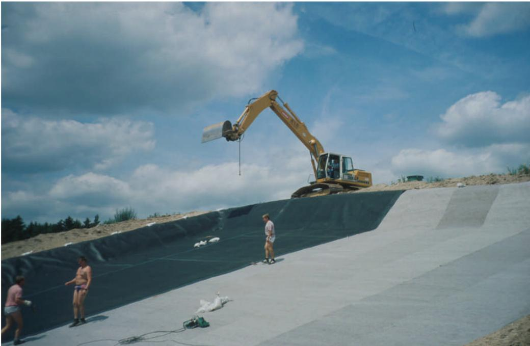
**Abbildung 5-4:** Verlegung der Kunststoffdichtungsbahn (= Basis des Großlysimeters).
