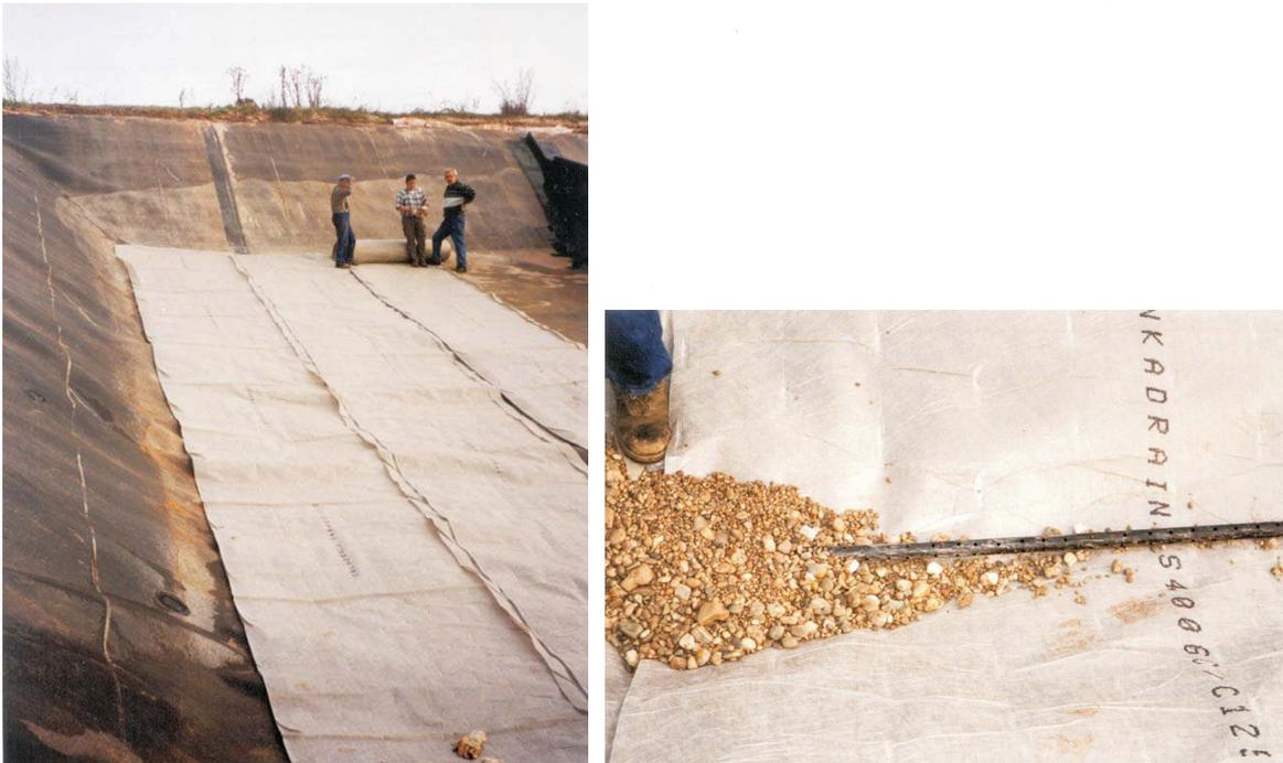
**Abbildung 4-5:** Verlegung der Dränmatte zur Wasserableitung unter der mineralischen Dichtung (Okt. 2001)
