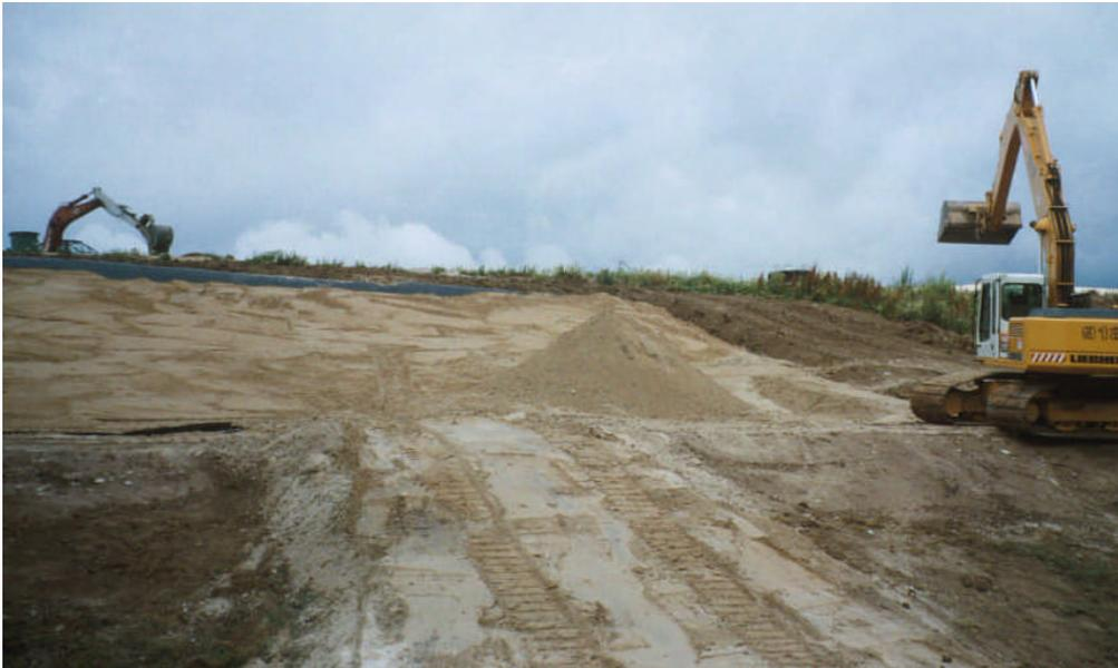
**Abbildung 5-8:** Einbau der Rekultivierungsschicht (Unterboden).
