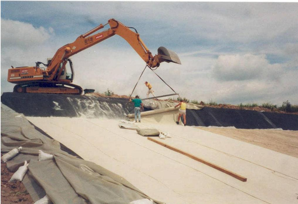
Abbildung 5-5: Verlegung der Bentonitmatte.
