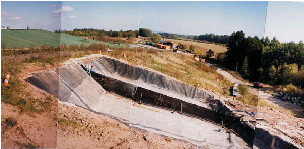
**Abbildung 4-4:** Umbau des Großlysimeters für das Versuchsfeld E 35 (September 2001)
