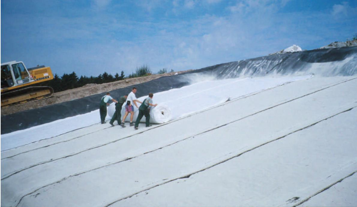
**Abbildung 5-7:** Ausrollen der Dränmatten als Entwässerungsschicht über der Bentonitmatte
