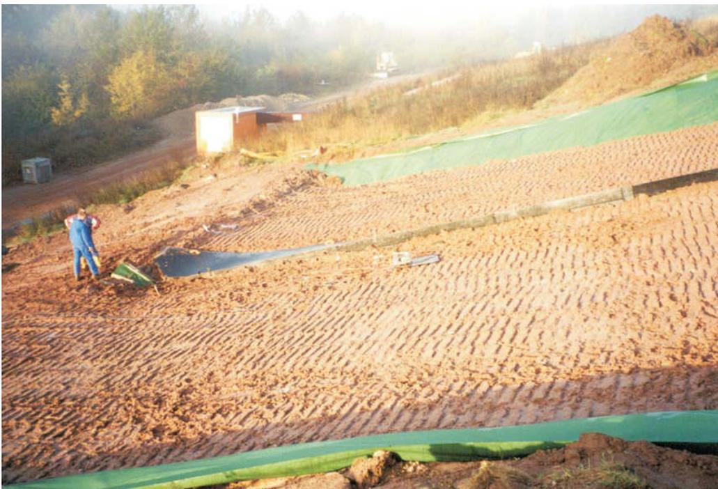
Abbildung 4-12: Einbau der Rekultivierungsschicht
