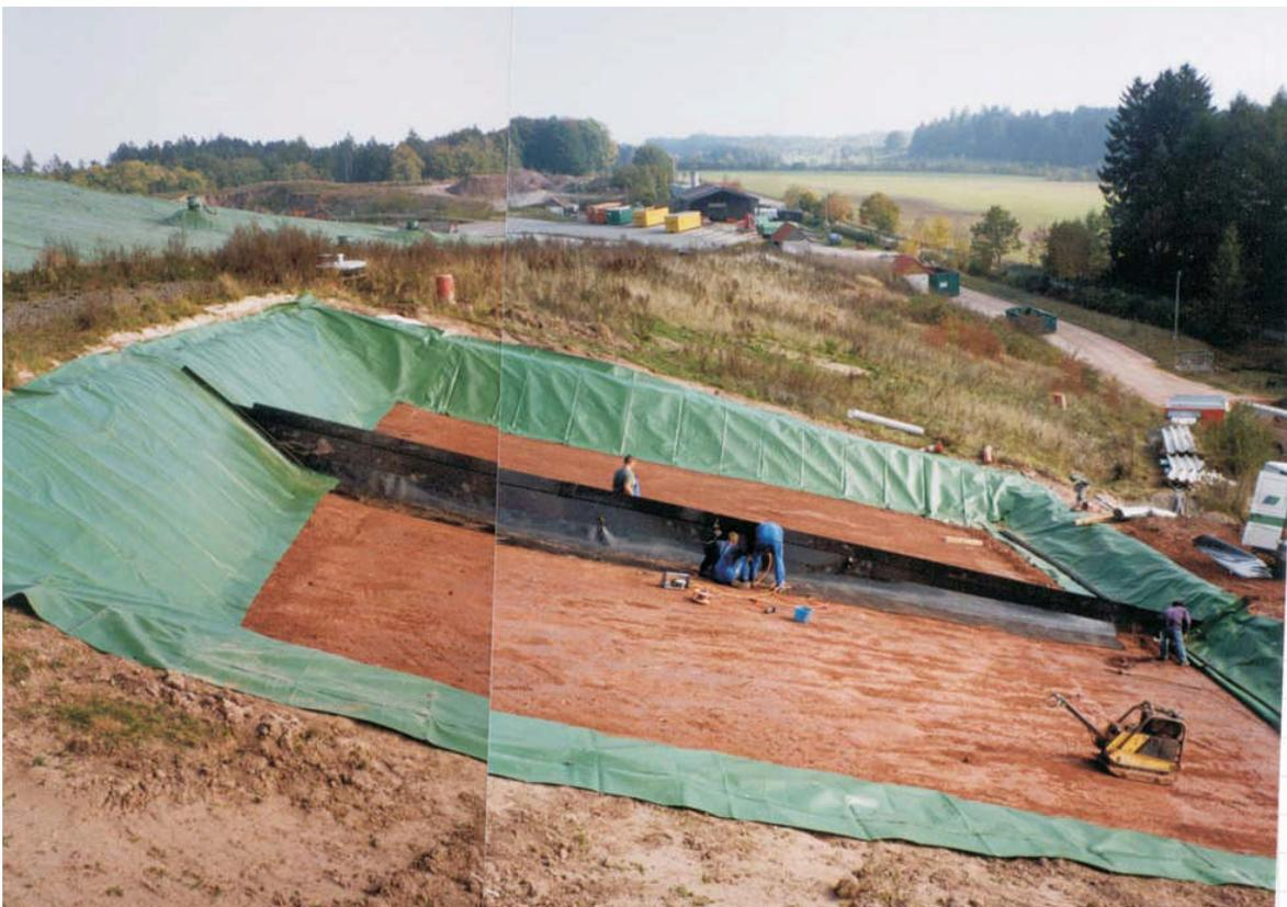
**Abbildung 4-10:** Verlegung von PELD-Dichtungsschürzen zur Unterbindung von Umläufigkeiten.
