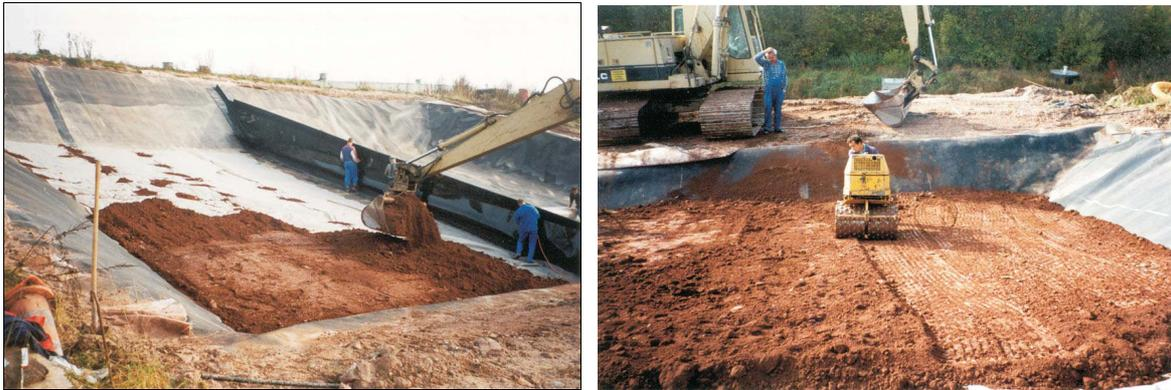
**Abbildung 4-6:** Einbau der mineralischen Dichtung (Oktober 2001).
