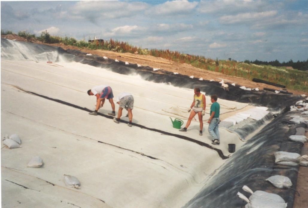
**Abbildung 5-6:** Verlegung und Verklebung der Bentonitmatte.
