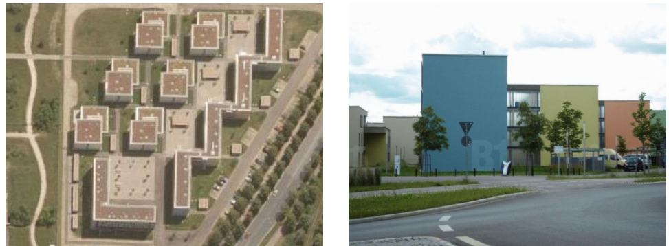
Abb. 2: Randbebauung: Die hohen Gebäude entlang der Straße schirmen die dahinterliegenden, niedrigen vom Verkehrslärm ab. Links: Draufsicht. Rechts: Seitenansicht.
